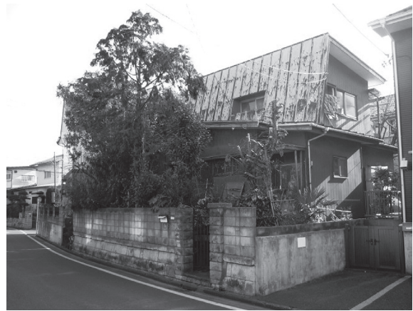
所沢市内の空き家
